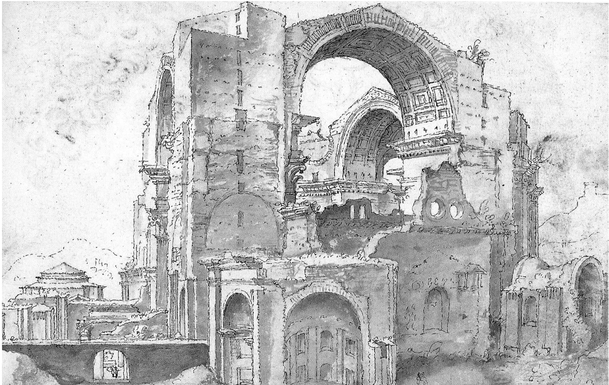
Die Baustelle Peterskirche als Ruine 1546. Zeichnung von Marten van Heemskerck
